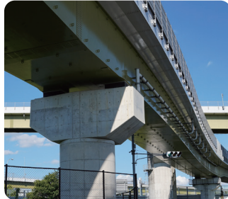
高架道路侧壁
